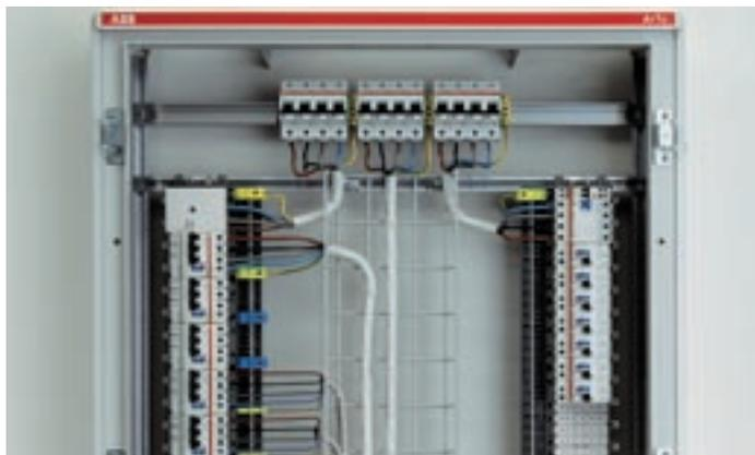
Автоматический выключатель с высокой отключающей способностью S800 может обеспечивать резервную защиту системы SMISLINE. Автомат S800 защелкивается прямо на верхней рейке. Питание подается в систему втычных устройств через короткую питающую линию и вводной клеммный блок.
